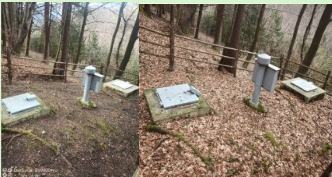
Slika 9: Očiščena in zagrajena okolica okoli vodovodnega objekta
