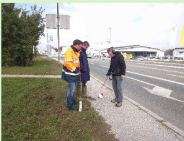
Slika 10: Iskanje puščanja vode s pomočjo Geofona Aqua M300
