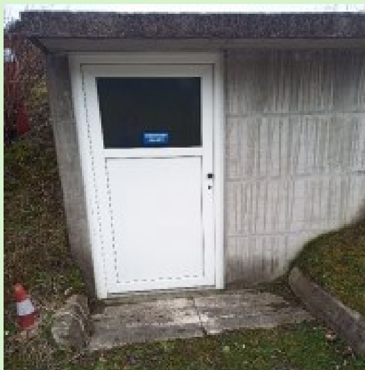
Slika 2: Vodovodni objekt za vaški vodovod Cirkuše-Mali Hrib
