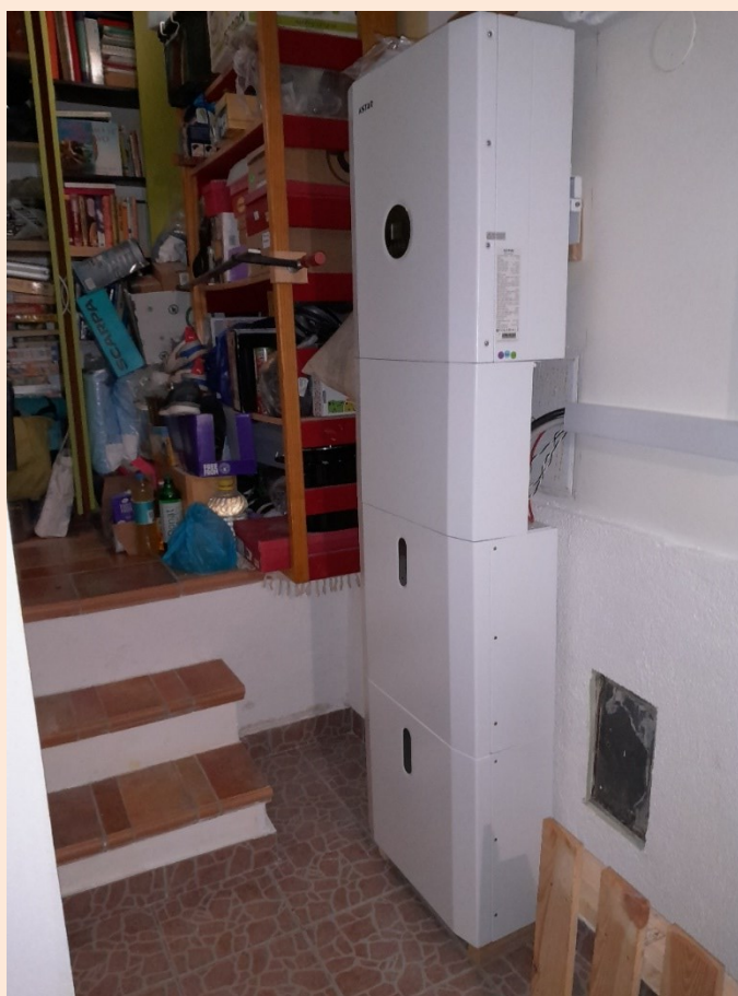
Slika 6: KStar E10 razsmernik z hranilnikom
